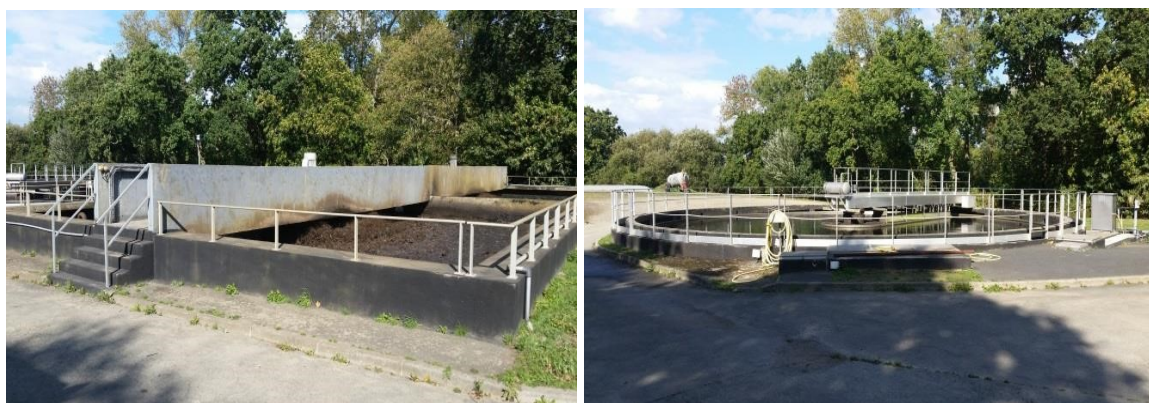
Bassins d'aération (à gauche) et clarificateur (à droite)
