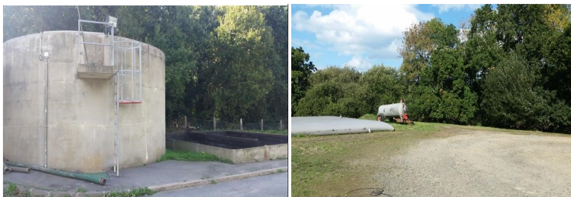
Silo épaisseur avec lits de séchage et réserve souple de stockage des boues
